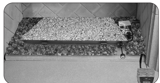
Fig. 17-4 Place vermiculite
